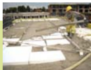
Ocieplenie dachu z przekładą styropianową
