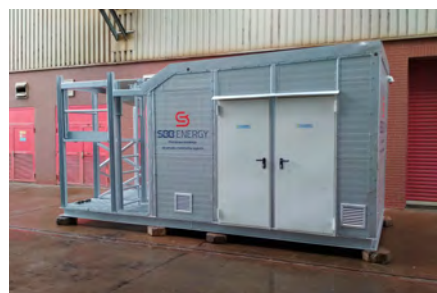
Rysunek 1. Kontener posadowiony na obiekcie
